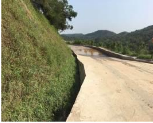
施工便道区截排水沟现状
