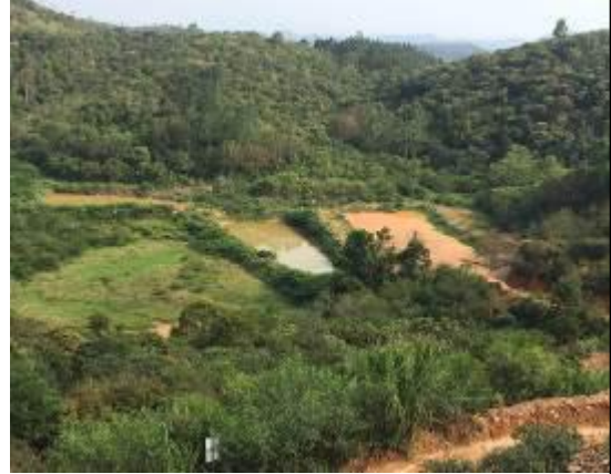
堆渣场区内沉沙池
