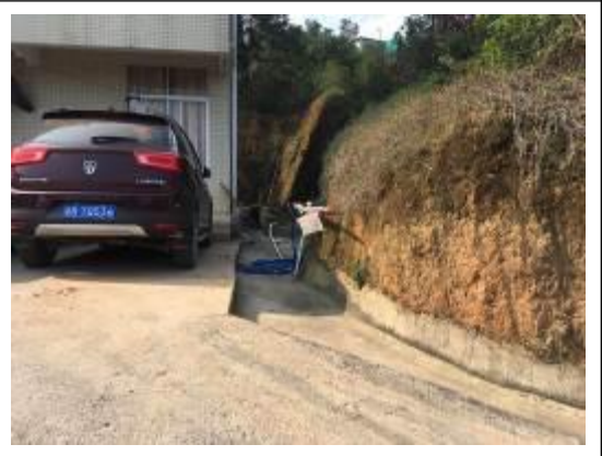
施工营造区排水沟现状
