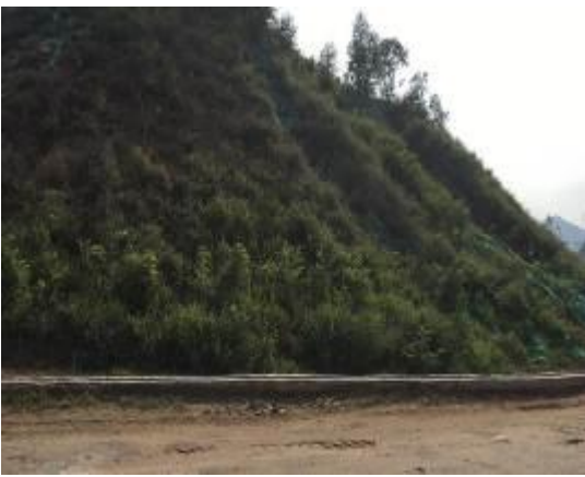
堆渣场区绿化及截排水沟
