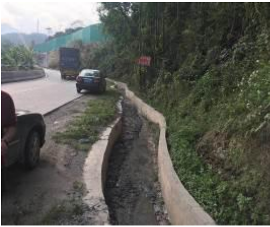
施工便道区截排水沟现状
