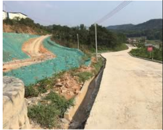
施工便道区截排水沟现状
