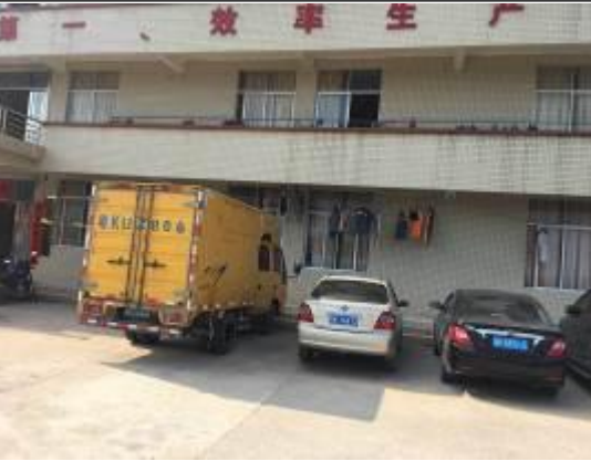
施工营造区现状
