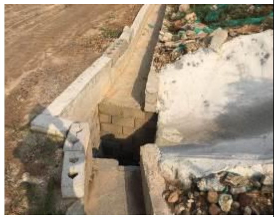
堆渣场地下暗管现状
